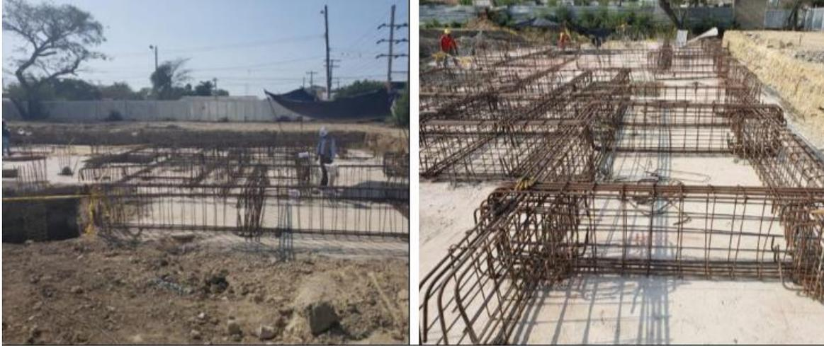
*Acero de vigas de cimentación (véase plataforma de concreto de limpieza)*
